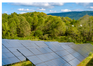
Installation de centrales solaires photovoltaïques
